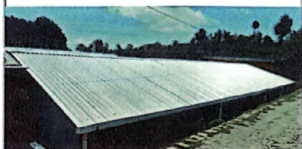
Foto 2: Obra finalizada de sustitución de lámina por lamina troquelada alucin calibre 26.
