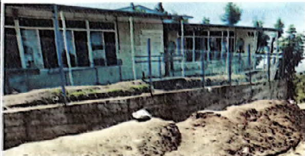
Foto 1: Finalización de muro perimetral de block con tubo HG y malla galvanizada, soleras.
