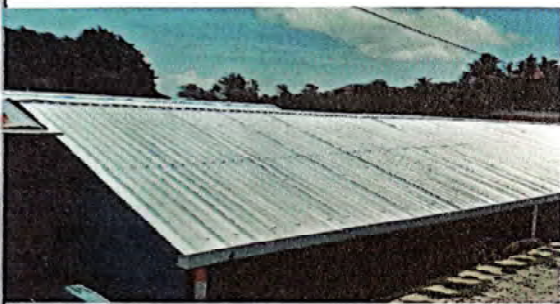
Foto 3: Finalización de la sustitución de canales de PVC alto caudal con pescantes de 1 x 3/16 @ 1.00m
