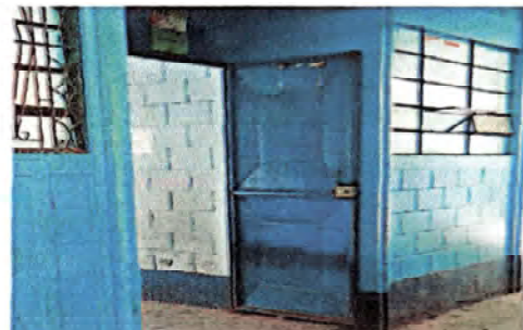
Foto 4: Chapa de puerta instaladas.
