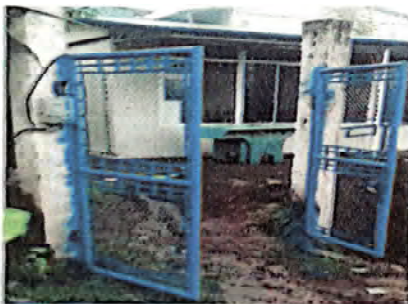
Foto 5: Mantenimiento del portón Finalizado
